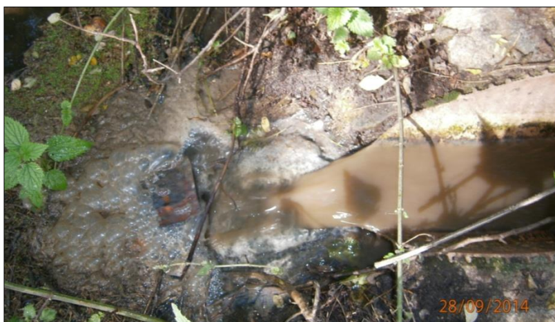
Foto 5 Vypouštění „vyčištěných odpadních vod“ z ČOV Mackovice (září)
