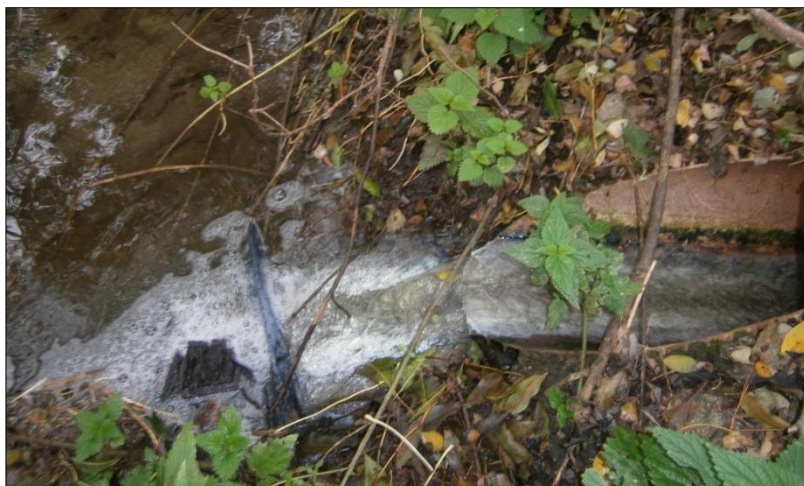
Foto 4 Vypouštění vyčištěných odpadních vod z ČOV Mackovice (říjen)
