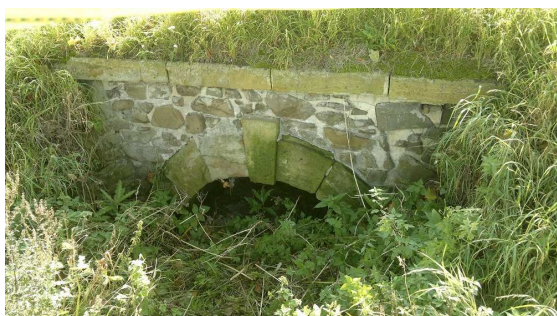
Obr. 14 Propustek km 1,753 (zdroj: autor, 2014)
