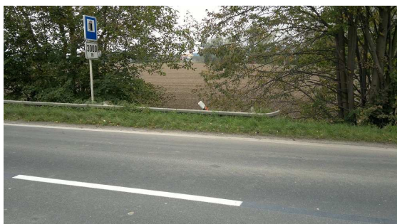
Obr. 71 Špatný směrový náběh (zdroj: autor, 2014)
