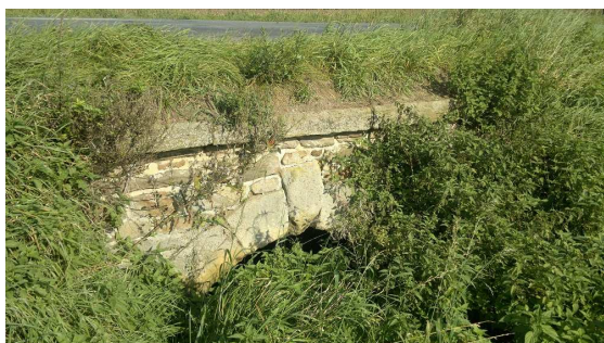
Obr. 16 Pravá strana (zdroj: autor, 2014)
