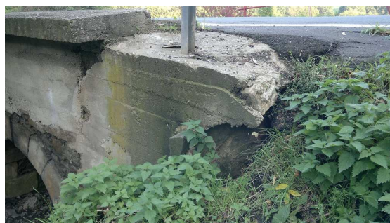
Obr. 46 Utržený segment (zdroj: autor, 2014)
