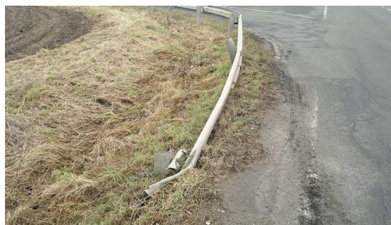
Obr. 21 Náběh svodidla (zdroj: autor, 2015)
