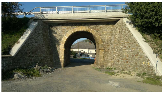
Obr. 33 Pravá strana (zdroj: autor, 2014)
