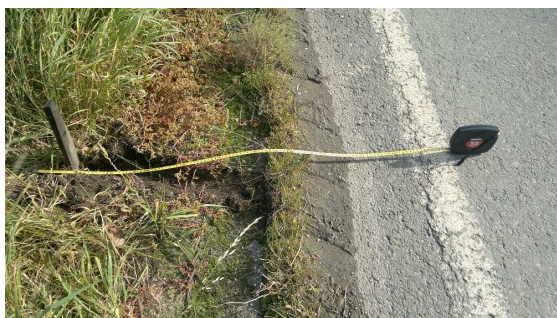
Obr. 10 Zanesená krajnice (zdroj: autor, 2014)
