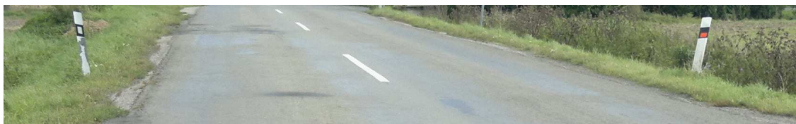
Obr. 24 Směrové sloupky (zdroj: autor, 2014)
