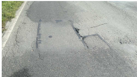
Obr. 8 Vysprávkování (zdroj: autor, 2014)
