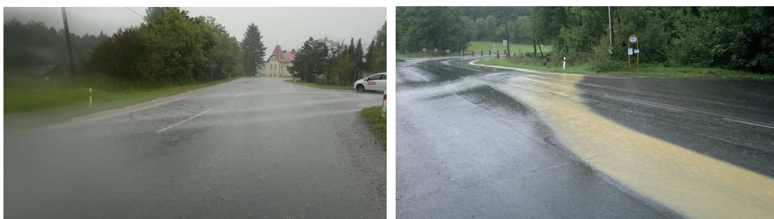
Obr. 52 Voda u vjezdu do lomu (zdroj: autor, 2014) Obr. 53 Voda u začátku úseku (zdroj: autor, 2014)
