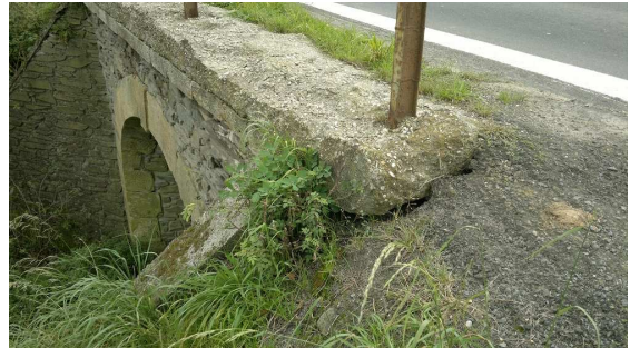
Obr. 62 Detail levé mostní římsy (zdroj: autor, 2014)
