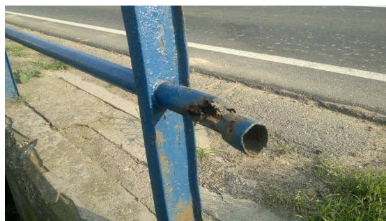
Obr. 75 Detail konce zábradlí (zdroj: autor, 2014)
