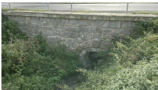
Obr. 12 Propustek v Paloníně (zdroj: autor,2014)
