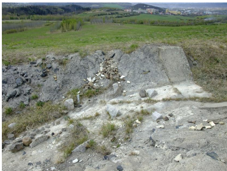
Obr. č.20. Přechod opevnění koryta z vegetačního na nevegetační (Myslíková 2012)
