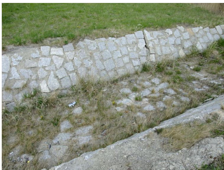
Obr. č. 19. Výtok z nádrže Jiřina opevněný kamennou dlažbou (Myslíková 2012)
