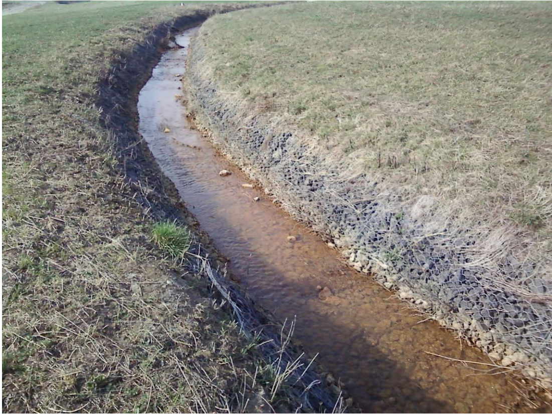
Obr. č.5 Radovesická výsypka - Koryto v oblasti rekultivace II.– drátokamenné opevnění (Myslíková 2011)
