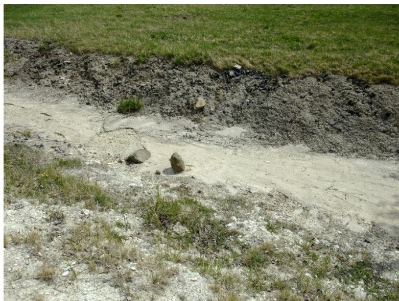
Obr.č 23. Nevegetační opevnění koryta v oblasti IV.RV (Myslíková 2012)
