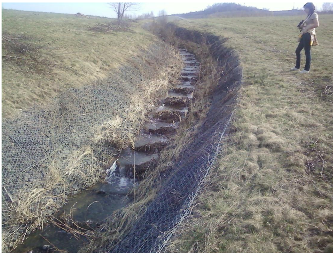
Foto 2 Koryto příkopu P1 s gabionovým opevněním dna se stupni (Myslíková 2011)
