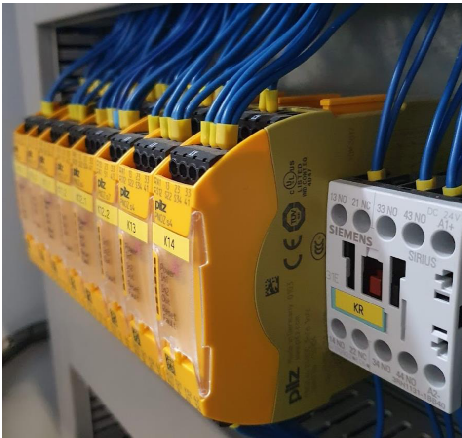
Obr. 18) Dvě řady svorek bezpečnostního relé PILZ PNOZ s4.
