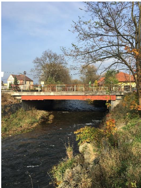
Obr.14: Konec ochranné zdi – silniční most u Jirsáka (Jílková 2018)
