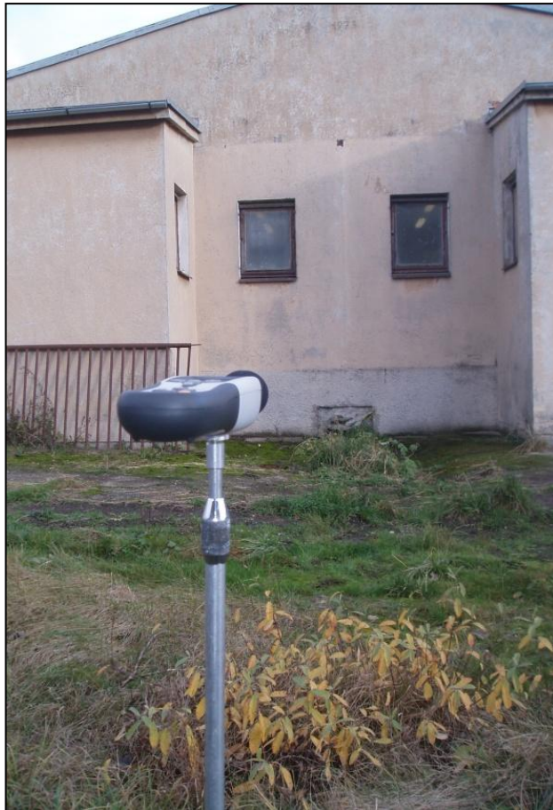
Obrázek 13: Pohled na budovu z místa měření č. 5
