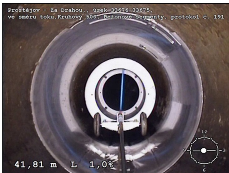
Obr. č. 28 - Zhotovená oprava Snap-Lock, Hermes technologie
