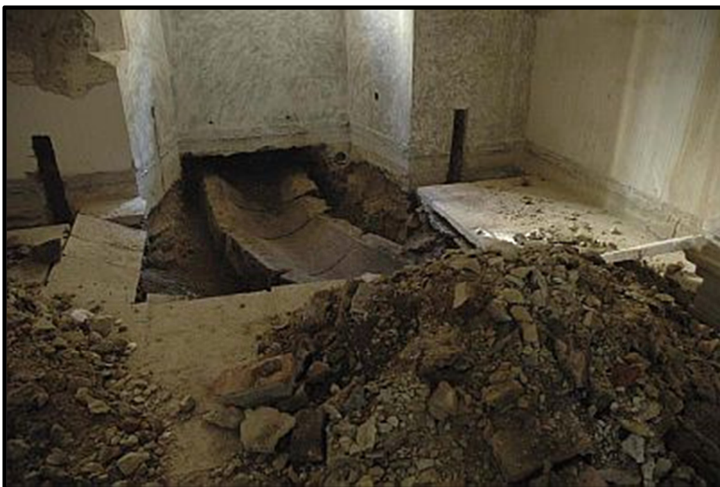
Obr. č. 1 - Historická kanalizace objevená v Klementinu
