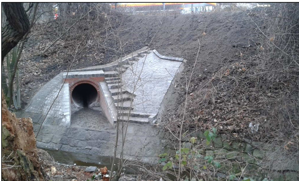
Obr. č. 25 - Gravitační výust' dešť'ového oddělovače po rekonstrukci, Krčské nádraží
