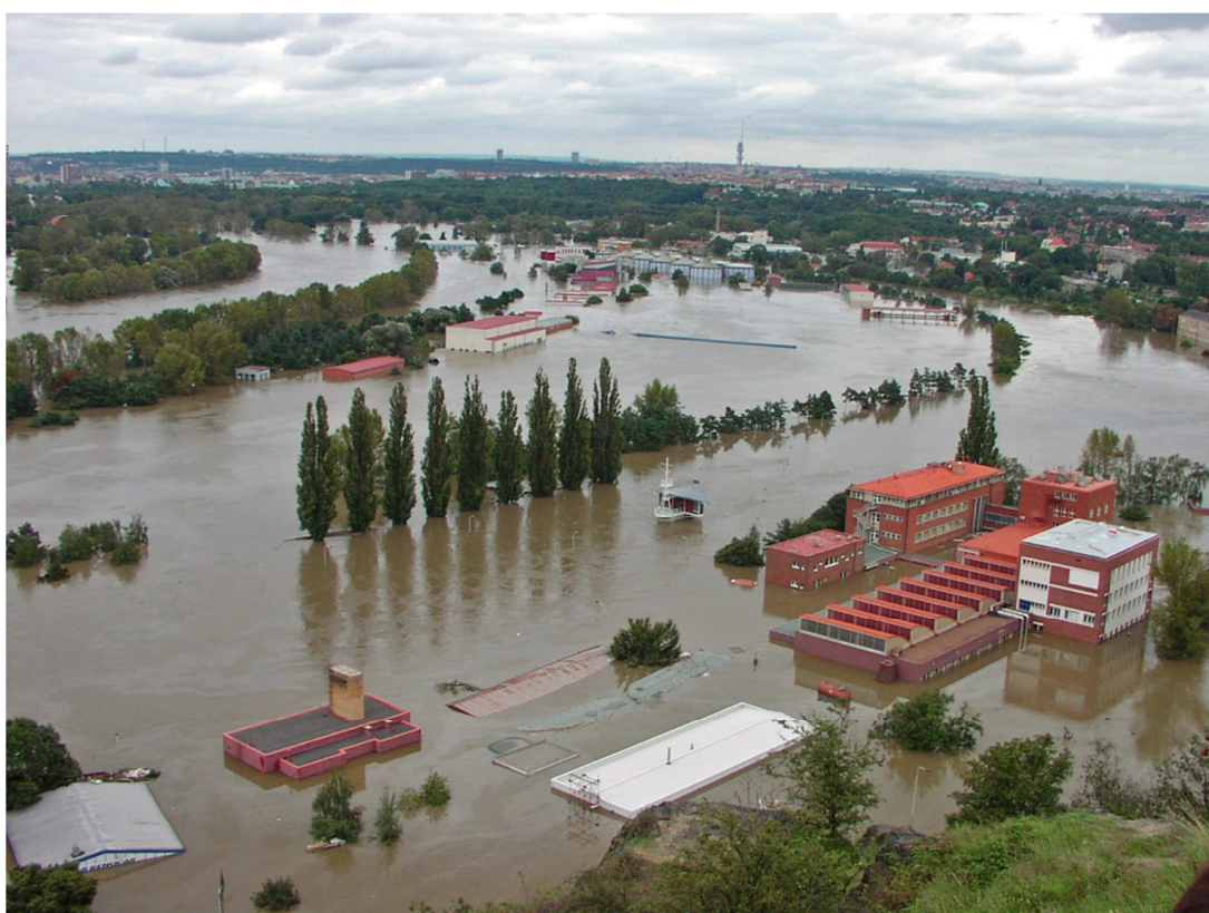
Obr. č. 9 - Pohled na ÚČOV ze dne 15. srpna 2002 kdy hladina Vltavy kulminovala
