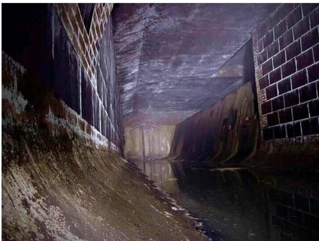
Obr. č. 7 - Pohled na zaslepenou část plánovaného štolového přivaděče v profilu DN 3350/4100
