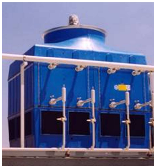
Obr. 15: Chladicí věž uzavřená- odpařovací kondenzátor vybavený skrápěnou trubkovnicí.
