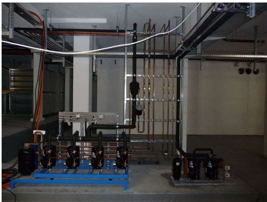
Obr. 10: Příklad sestavy sdružené chladicí jednotky - výkon 19kW
