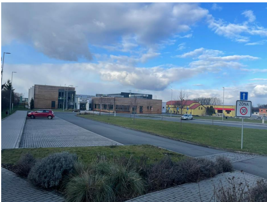
Obr. 11 - Nová budova základní školy a její příjezdová cesta, zdroj: autor
