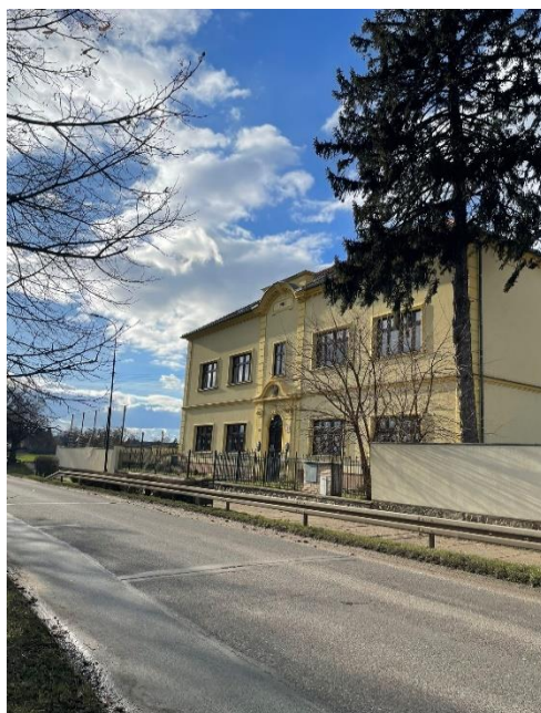
Obr. 6 - Stará budova základní školy, obec Veleň, zdroj: autor
