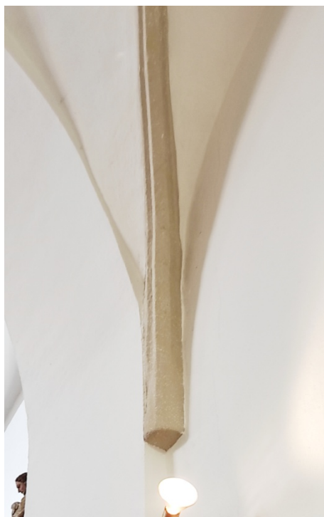
Vřesovice, kostel sv. Petra a Pavla, interiér, severozápadní klenební žebro – konec 15. století.
