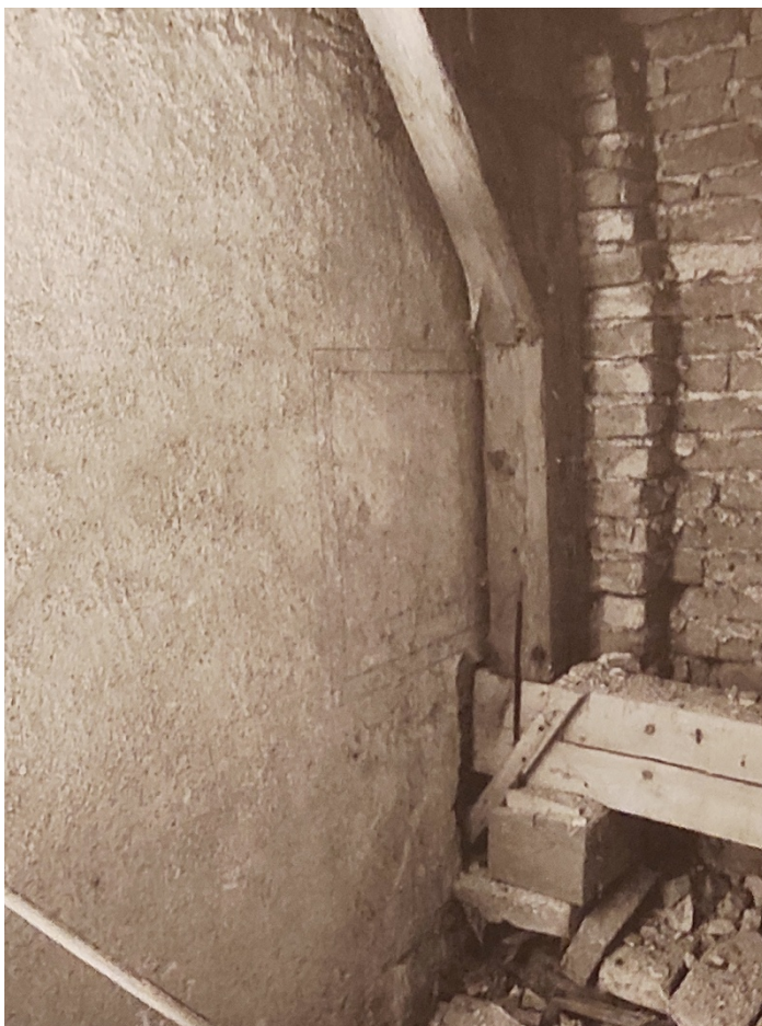
Vřesovice, kostel sv. Petra a Pavla, podkroví, zachované barokní omítky, 80. léta 17. století.
