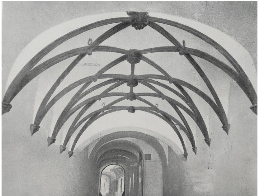
Praha, Dům U zlatého jednorožce, klenba – 1496.
