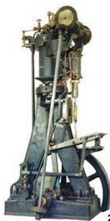
Obrázek 4: První motor Rudolfa Diesela [1]
