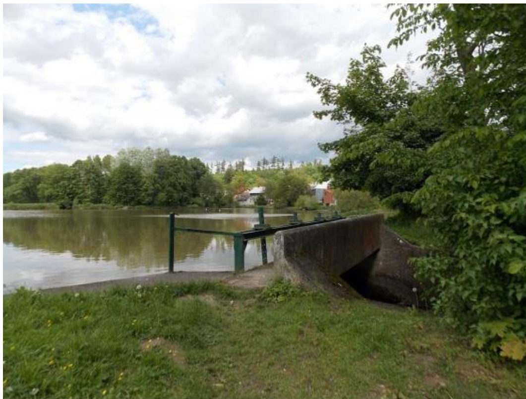
Obr. 8 Pohled na výpustné zařízení zámeckého rybníku
