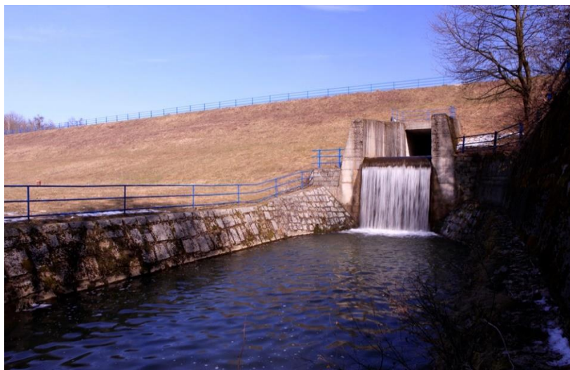
Obr. 6 Sdružený objekt na vzdušné straně hráze [10]
