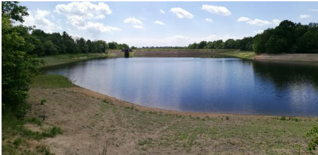
Obr. 5 Pohled na návodní stranu nádrže Tršice [10]
