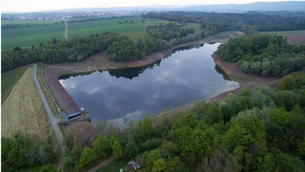
Obr. 4 Pohled na nádrž Tršice
