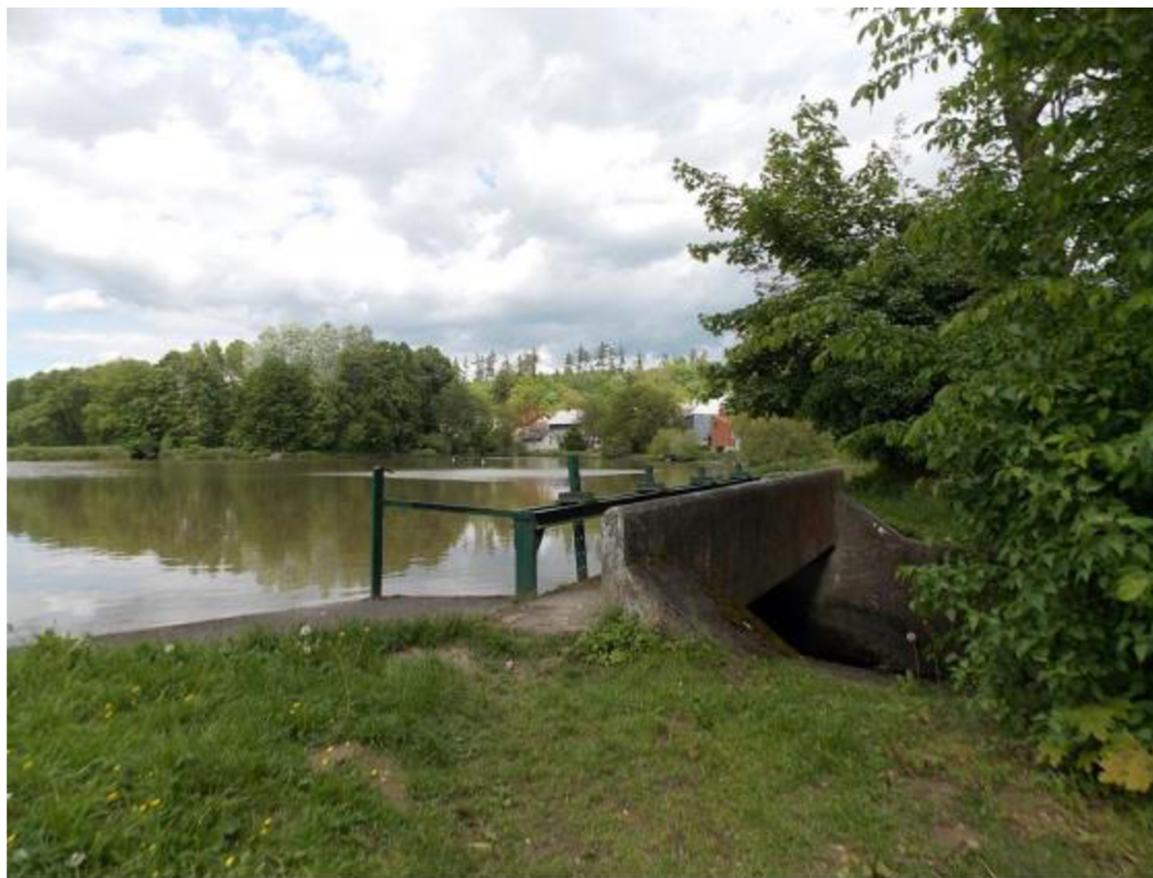
Obr. 8 Pohled na výpustné zařízení zámeckého rybníku
