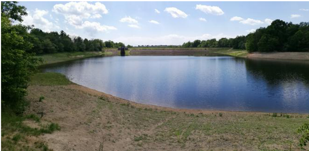
Obr. 5 Pohled na návodní stranu nádrže Tršice [10]
