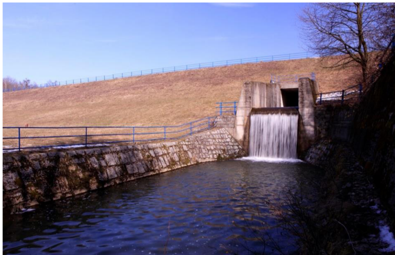
Obr. 6 Sdružený objekt na vzdušné straně hráze [10]
