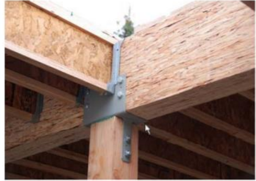
Obr. 16: LSL a jeho použití na nosník (Augustin a kol. 2008)
