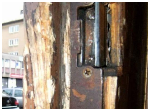
Obr. 5: Stopa v místě páčení zámku
