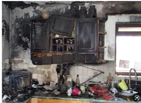
Obr. 9: Požár vzniklý defektem rychlovarné konvice
