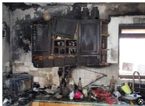
Obr. 9: Požár vzniklý defektem rychlovarné konvice
