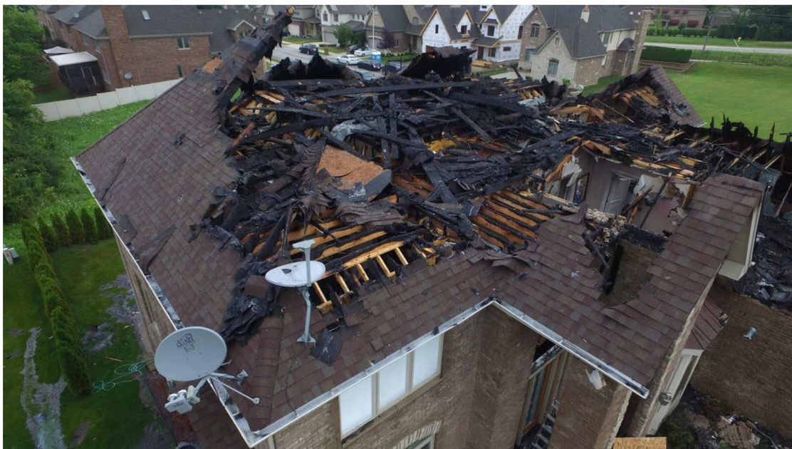
Obr. 12: Využití dronu pro ohledání místa požáru
