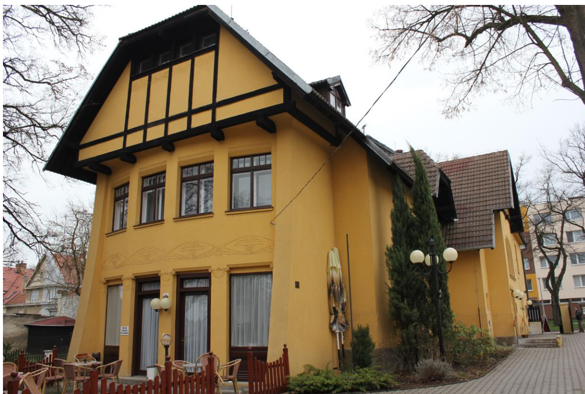
Jan Kotěra, Vila Vendelína Máchy, Libušina 188, Bechyně, 1902-1903.
