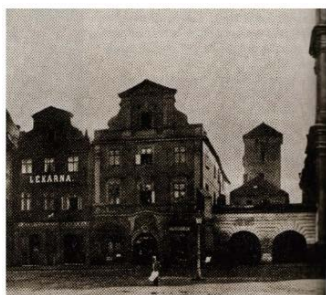
Obrázek 33: Starý pohled na vodárenskou věž
