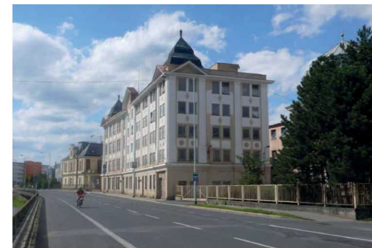
Obr.4 A,B - objekt 1217701212 0002 - Pradiareň a sklad z roku 1922 podľa projektu arch. Franza Ehrenbergera. Dve samostatné budovy so železobetónovým skeletom, prepojené schodiskom s jednotnou fasádou v klasicistnom výraze.
