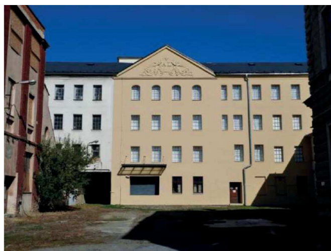
Obr.6 E1, E2 - objekt 1217701212 0001 - tkáčovňa.
