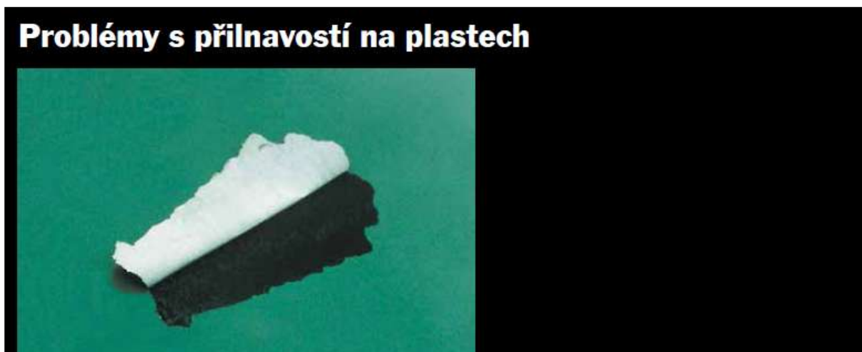
Obr. č. 10 - Problém s přilnavostí na plastovém povrchu (Standothek, 2015)
