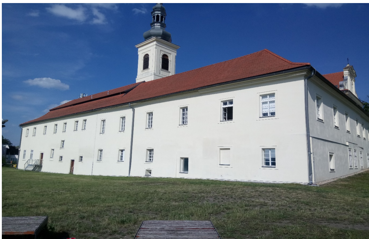
Obr. 13 Karmel (bývalé centrum Jednoty bratrské) – budova bývalého kláštera
