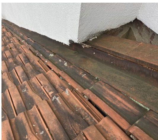
Obrázek 18 - Současný stav střešní krytiny, zdroj: (vlastní)
