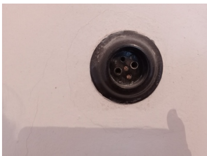
Obrázek 23 - Současný vzhled zásuvek, zdroj: (vlastní)
