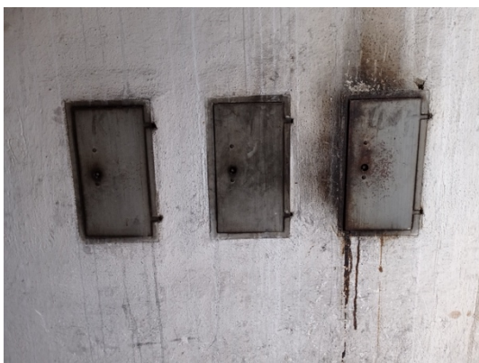
Obrázek 20 - Současný stav vymetacího otvoru, zdroj: (vlastní)
