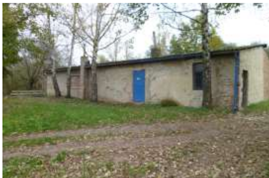
Obr. č. 50 - Pohled na objekt bývalé střelnice od příjezdové komunikace (stav k 10/2014); vlastní foto autora
