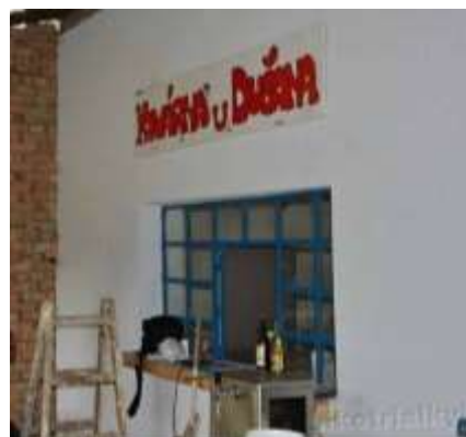
Obr. č. 53 - Opravená část střelnice (stav k 06/2015) 103
