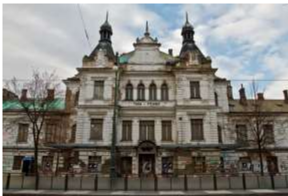
Obr. č. 4 - Nádraží Vyšehrad, Praha 2 33
