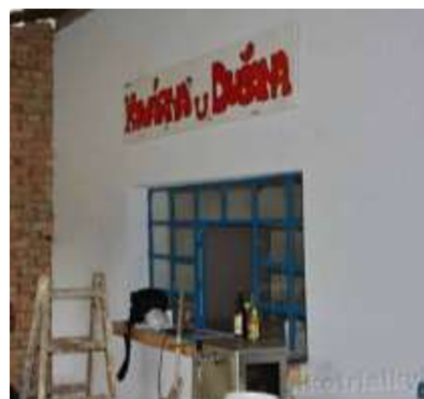
Obr. č. 53 - Opravená část střelnice (stav k 06/2015) 103
