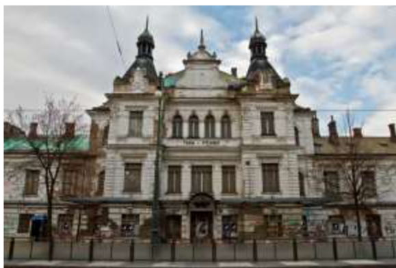
Obr. č. 4 - Nádraží Vyšehrad, Praha 2 33
