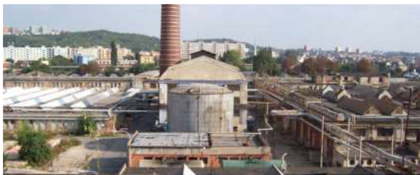
Obr. č. 3 - Areál Zbrojovky Brno 31
