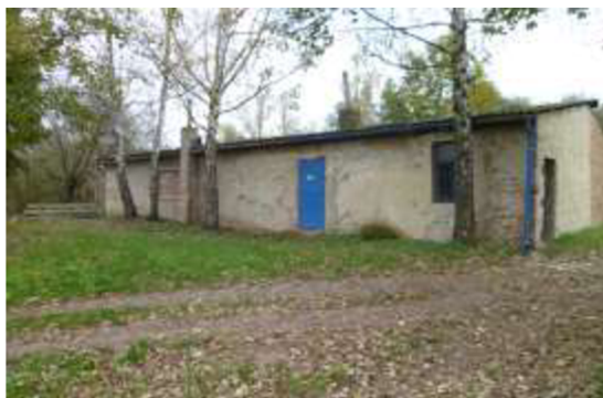
Obr. č. 50 - Pohled na objekt bývalé střelnice od příjezdové komunikace (stav k 10/2014); vlastní foto autora
