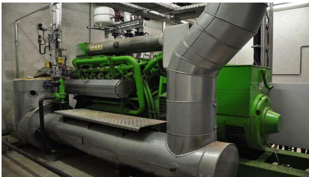
Obr. 3: Kogenerační jednotka BPS
