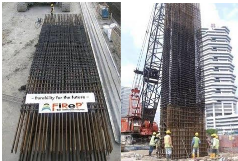
Obrázek 27 Armokoš hloubené stěny při výstavbě linky metra Circle Line v Singapuru [5]
