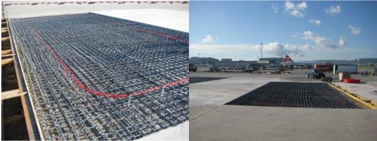
Obrázek 19 Aplikace FRP výztuže při rekonstrukci runway na letišti v Curychu [5]
