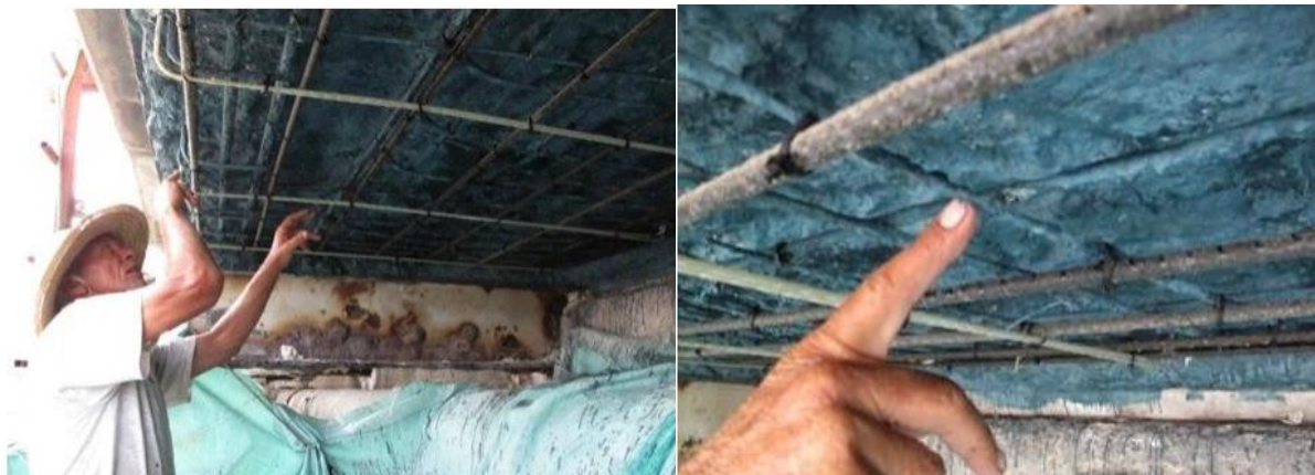
Obrázek 24 Sanovaný spodní líc mostovky s dovyztužením CFRP a GFRP [20]
