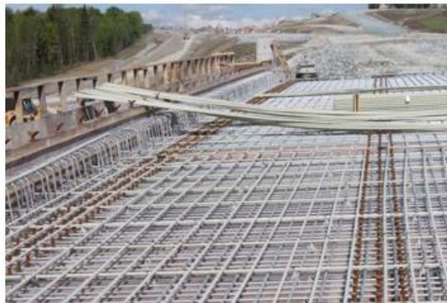
Obrázek 22 Instalace výztuže mostovky Twin Bridges [19]
