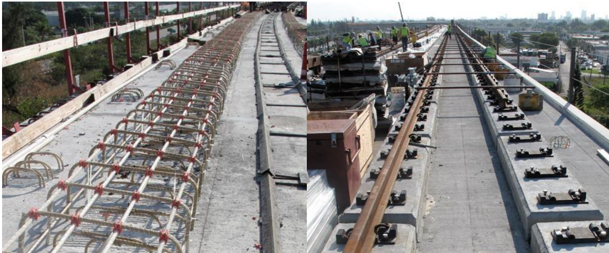
Obrázek 20 Výstavba železničních pražců Miami-Dade MetroRail [18]
