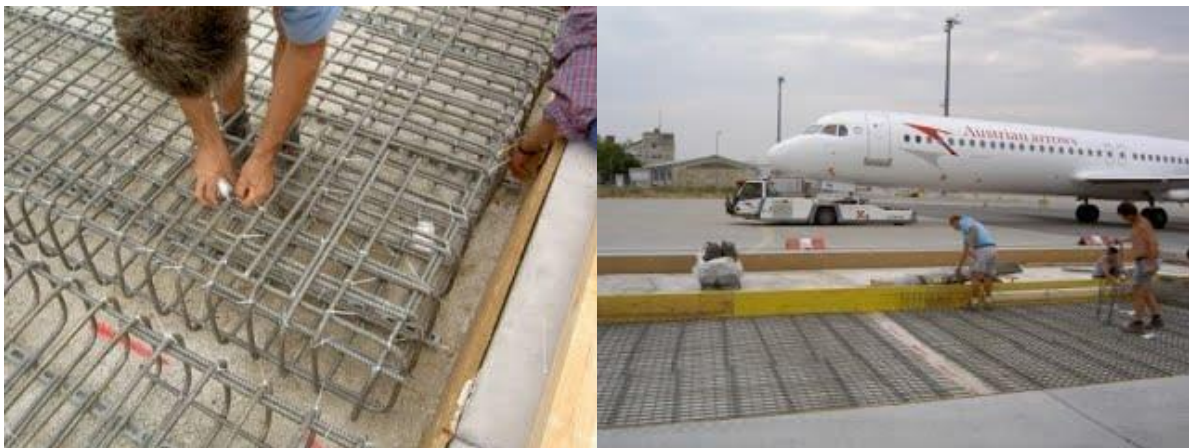
Obrázek 18 Vyvazování FRP výztuže při rekonstrukci přistávací dráhy letiště ve Vídni [5]
