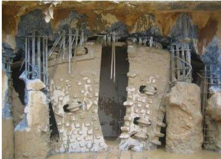
Obrázek 26 Průchod řezné hlavice portálem tunelu v Kuala Lumpur vyztuženým FRP výztuží [5]
