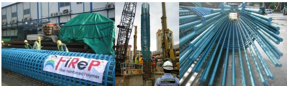
Obrázek 28 Armokoše pilotové stěny při výstavbě linky metra Downtown Line v Singapuru [5]
