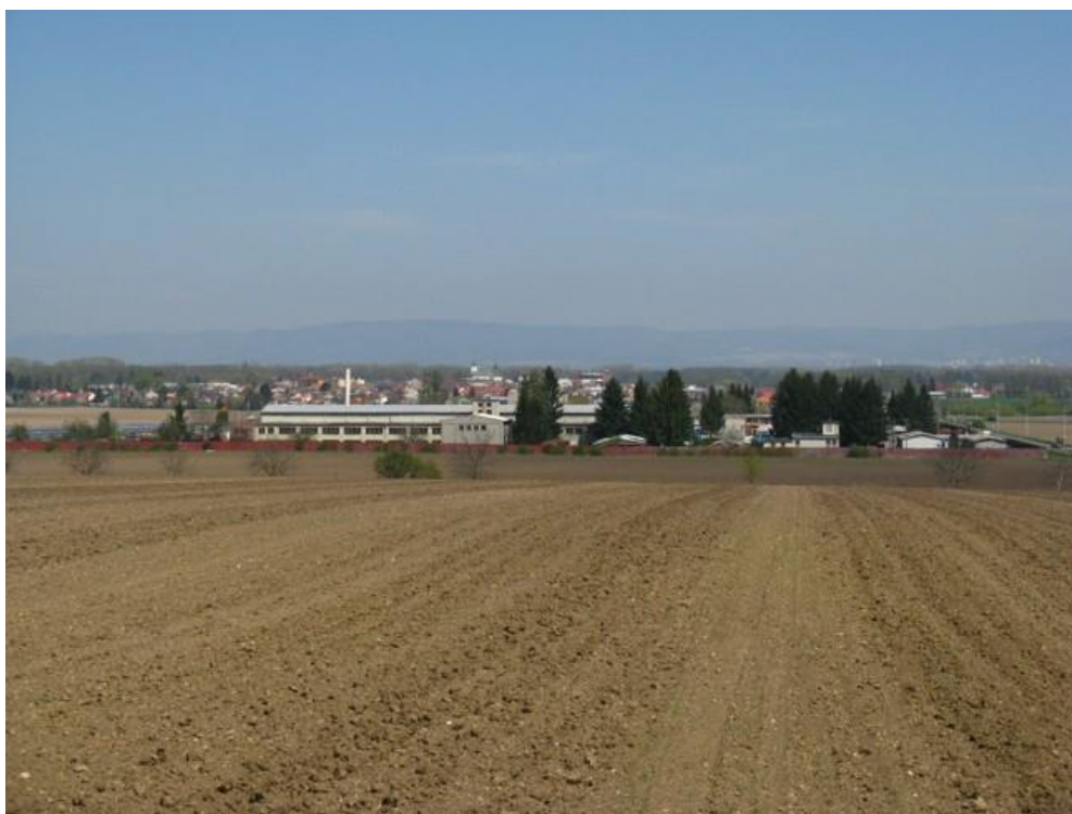
Obr. 7 Bývalý vojenský opravárenský závod (uprostřed), v pozadí obec Horka nad Moravou dne 24. 4. 2015 (vlastní fotodokumentace)
