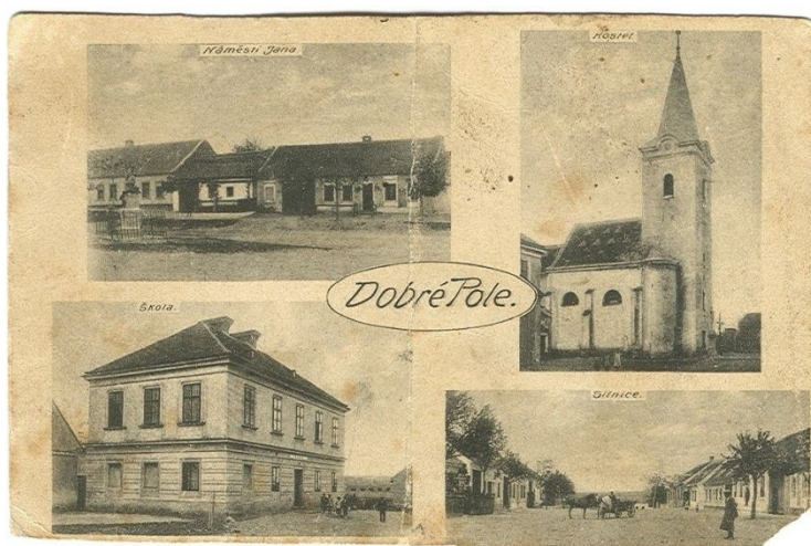
Obr. 55 Historická pohlednice z obce Dobré pole (zdroj:www.dobrepole.cz)
