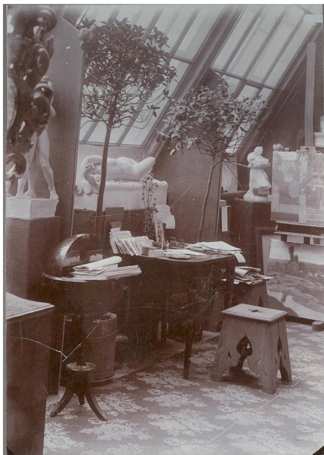
6. Kalvodův ateliér na Vinohradech v Praze, nedat. (mezi 1900-20)
