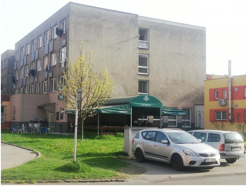
Obr. 20 Lokalita č. 3 panelové domy v ul. Máchova, Nádražní, Dvořákova – bližší pohled
