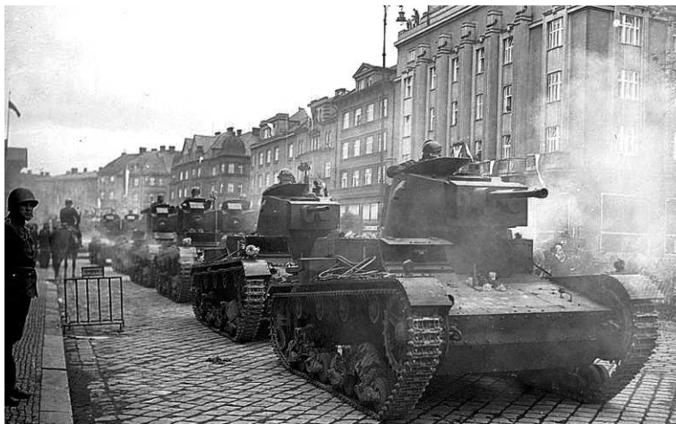
obrázek 7 - Tanky projíždějící Českým Těšínem 107
