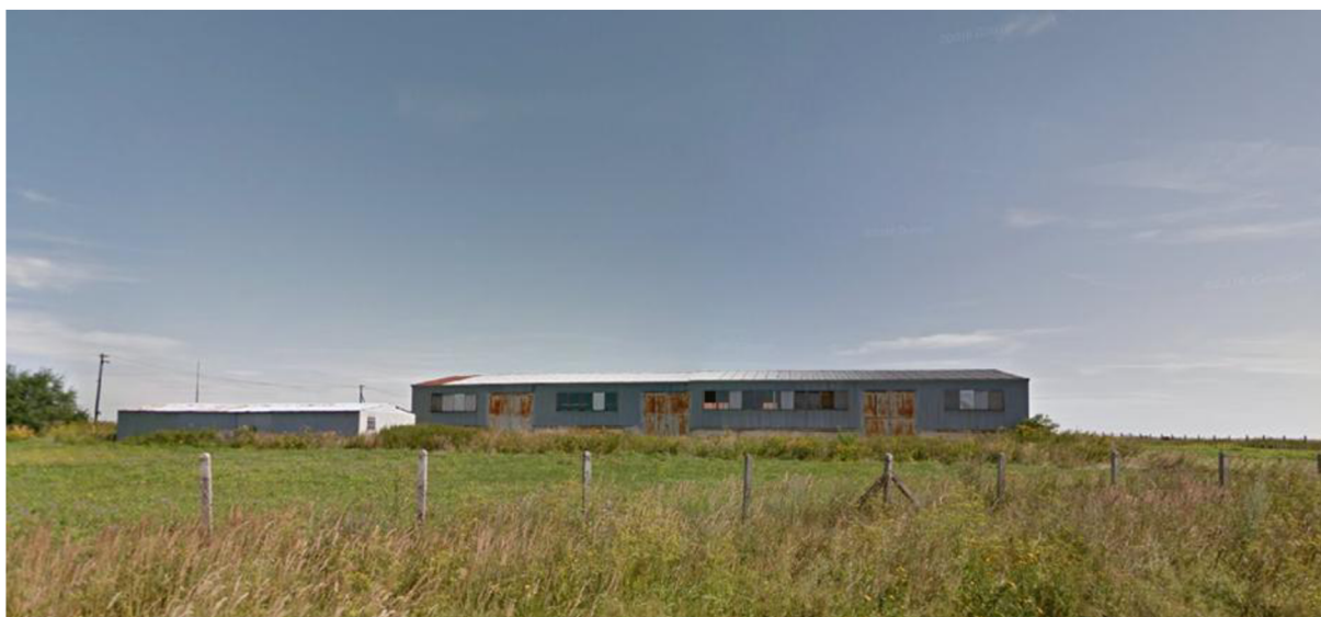
Obrázek 6: Skladová hala, na které došlo 26. 6. 2015 ke škodné události způsobené požárem
