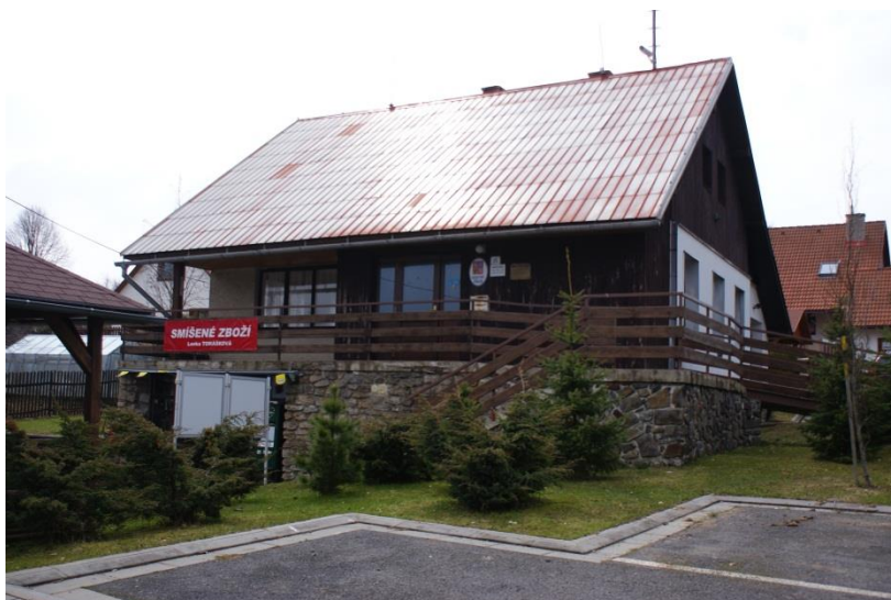
Obrázek č. 2: Budova obecního úřadu na Třech Studních – pohled z parkoviště
