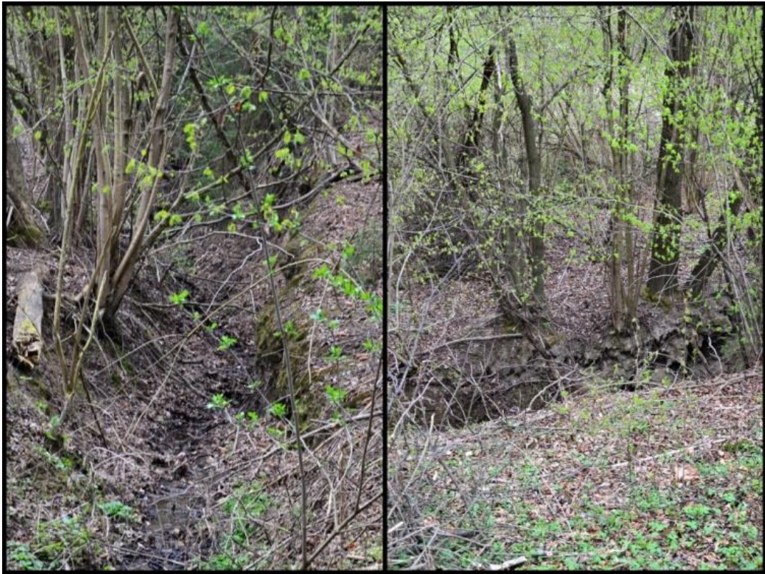
Obr. 76.: Koryto bezejmenného potoka porušené erozí (Dominika Balatková, 2017)
