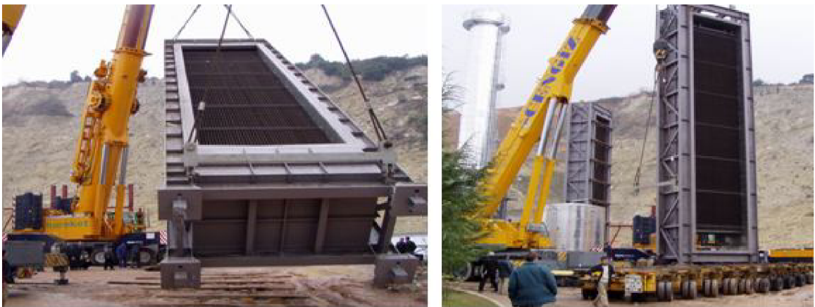
Obr.16. Osadzovanie modulov spalinového kotla
