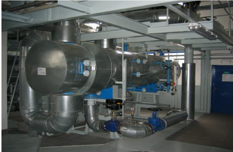
Obr. 20. Horizontálny rúrkový parný ohrievač sieťovej vody
