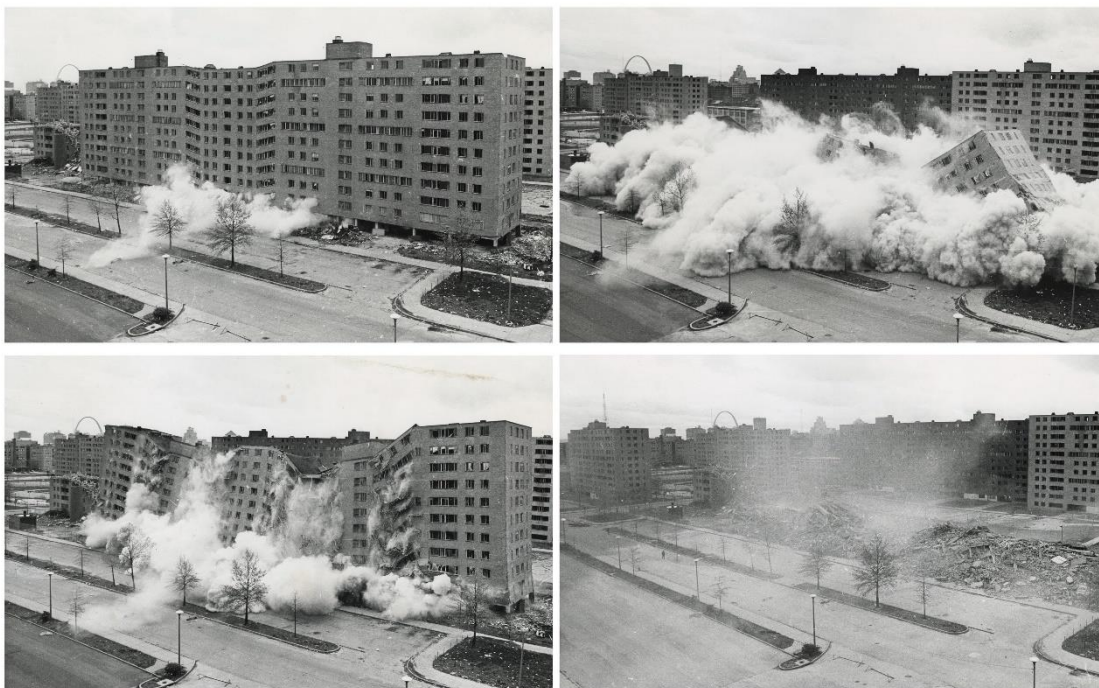
Obrázek 2: Sídlíště Pruitt-Igoe - demolice Zdroj: medium.com
