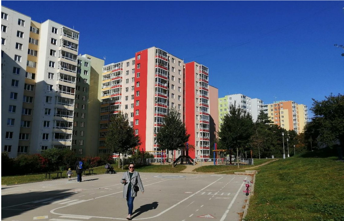
Obrázek 34: Sanace lodžií a vhodná barevá kombinace Zdroj: autorka práce
