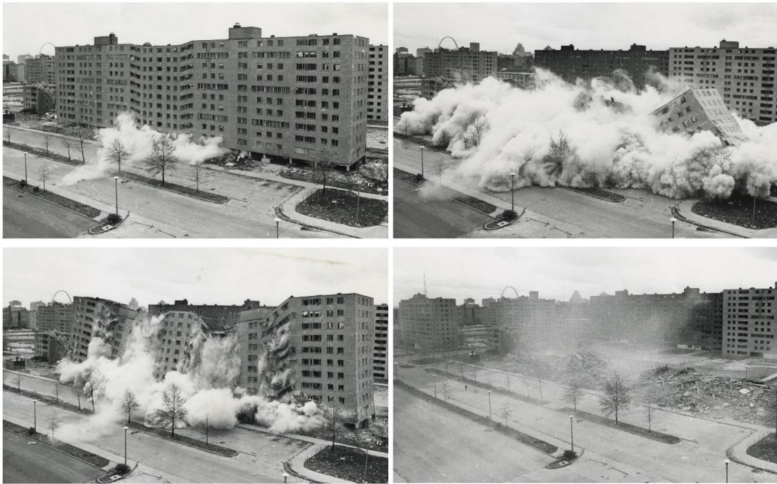
Obrázek 2: Sídlíště Pruitt-Igoe - demolice Zdroj: medium.com
