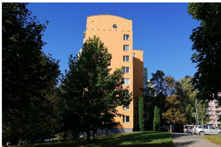
Obrázek 32: Pohled na nástavbu panelového domu Zdroj: autorka práce
