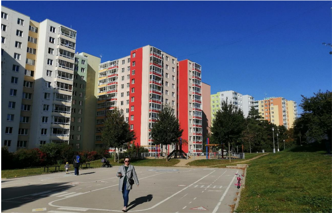
Obrázek 34: Sanace lodžii a vhodná barevá kombinace Zdroj: autorka práce
