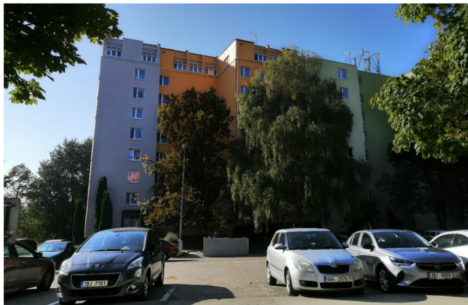
Obrázek 31: Nástavba na osmipodlažním panelovém domě Zdroj: autorka práce
