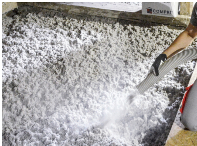
Obr. 6 Obrázek vyobrazující použití foukané izolace (Climatizer 2022).
