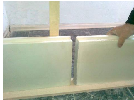
Obrázek 6: Příprava pro zdění (vlevo), způsob spojování sádrových tvarovek (vpravo)
