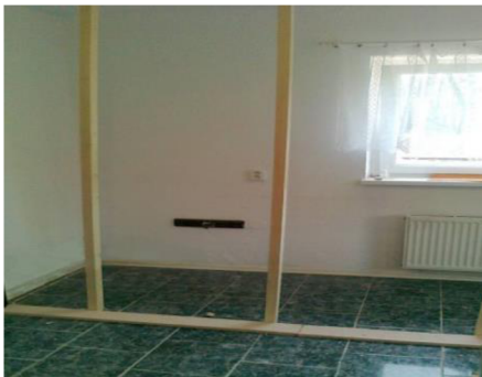
Obrázek 6: Příprava pro zdění (vlevo), způsob spojování sádrových tvarovek (vpravo)
