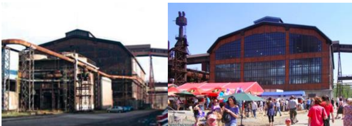
Obr. 8: Energetická ústředna před rekonstrukcí (Dolní Vítkovice, 2012)
