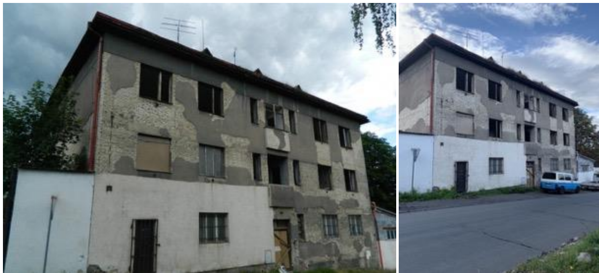
Obr. 36-37: Bytový dům Oldřichova 732 (Mačejová, 2022, Jiří Suchomel, 2016)
