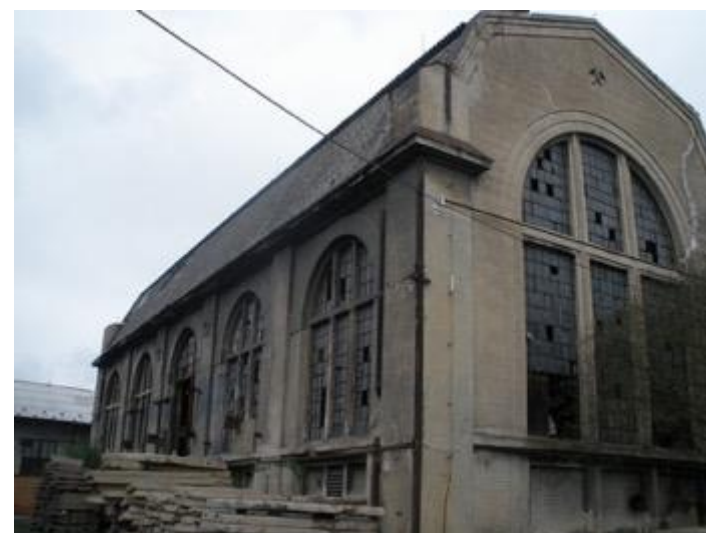
Obr. 41: Budova strojovny (Kladno minulé, 2014)
