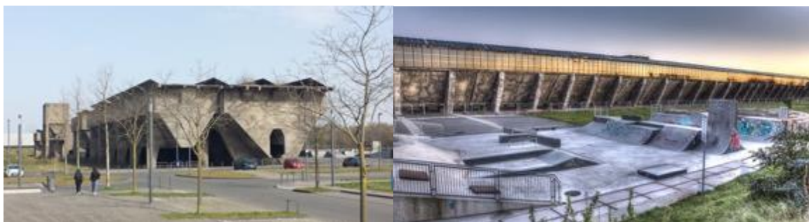
Obr. 18 Budova elektrické rozvodny (Ruhrgebirt Industriekultur, ©nedatováno)
