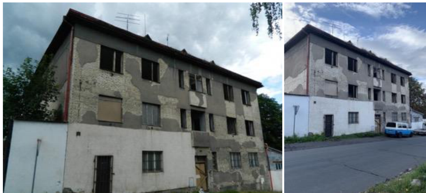
Obr. 36-37: Bytový dům Oldřichova 732 (Mačejová, 2022, Jiří Suchomel, 2016)
