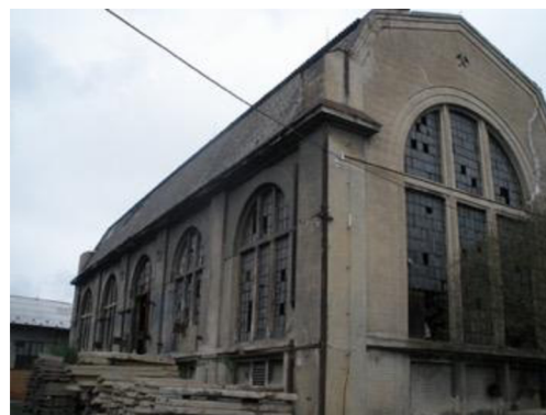
Obr. 41: Budova strojovny (Kladno minulé, 2014)
