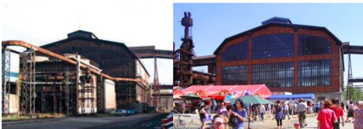
Obr. 8: Energetická ústředna před rekonstrukcí (Dolní Vítkovice, 2012)
