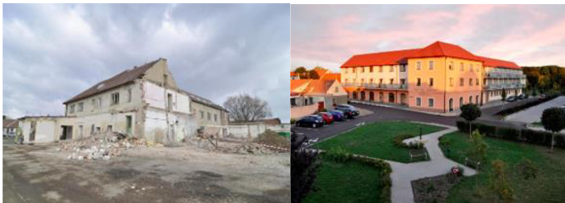
Obr. 6: Zemědělská budova JZD (Revitalizace brownfieldů, 2019)
