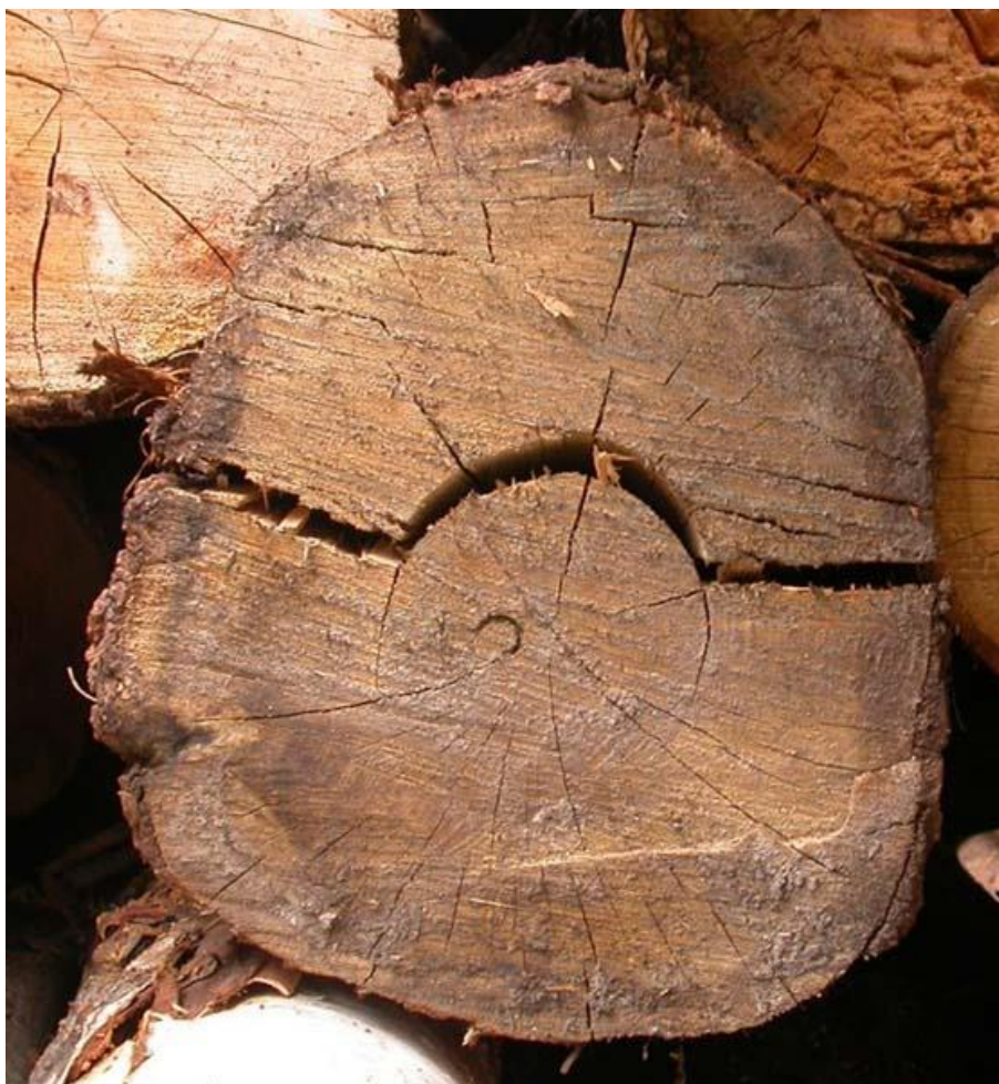
Obrázek č. 2 Odlupčivá trhlina
