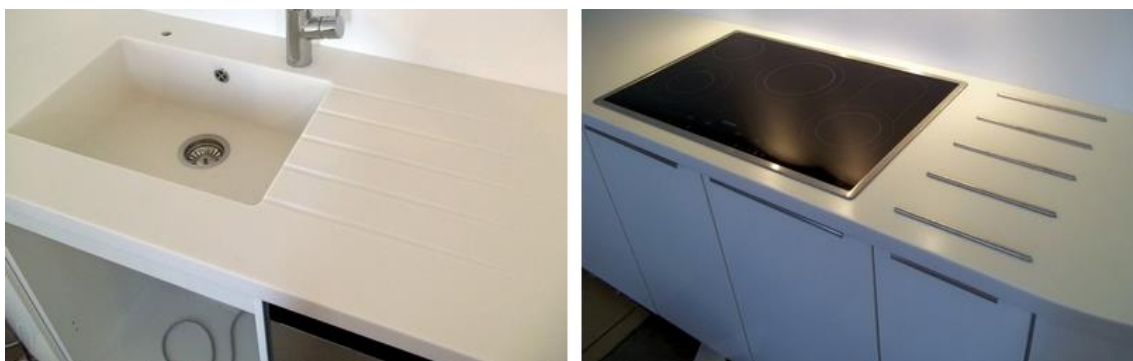
Obr. 5 „Odkapové“ drážky (vlevo) a odkládací plocha na horké předměty (vpravo)
