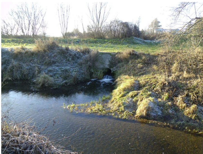
Obrázek 16: Stanoviště č. 2 (u vyústění ČOV)
