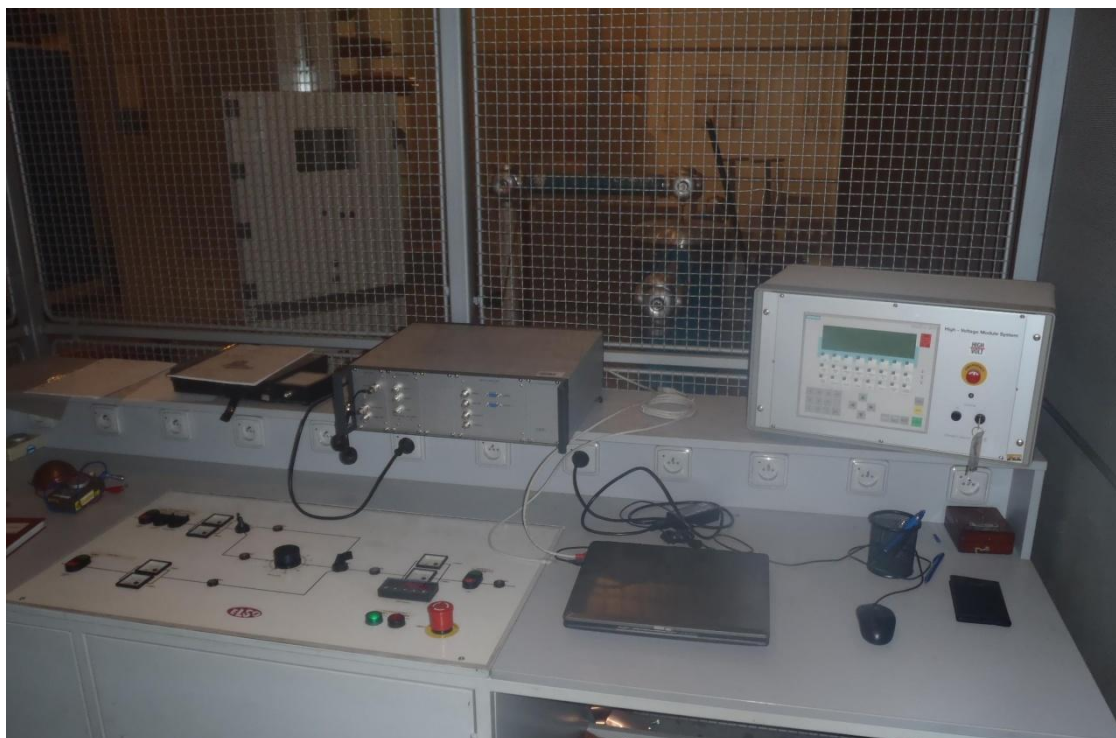
Obr. 30 Merací pult so zariadením LDS-6 v laboratóriu firmy ABB Brno
