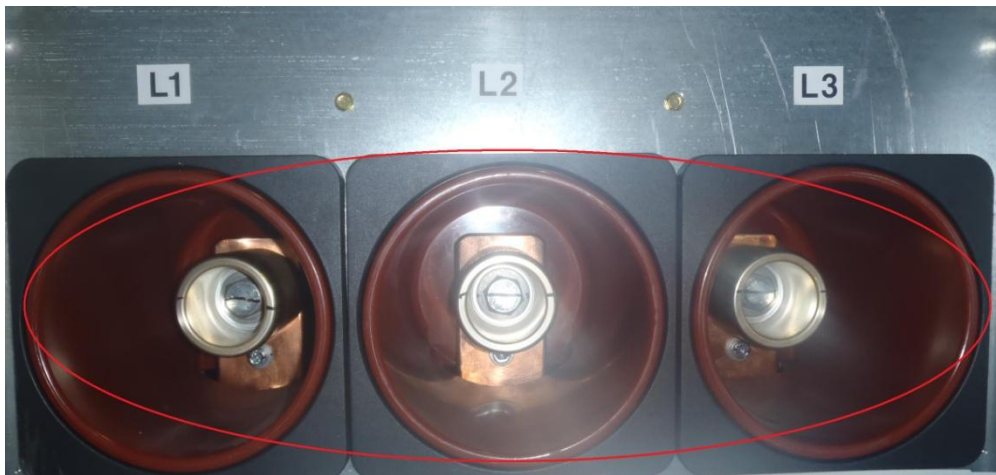
Obr. 19 Izolačné priechodky s vyznačenými možnými miestami vzniku čiastkových výbojov
