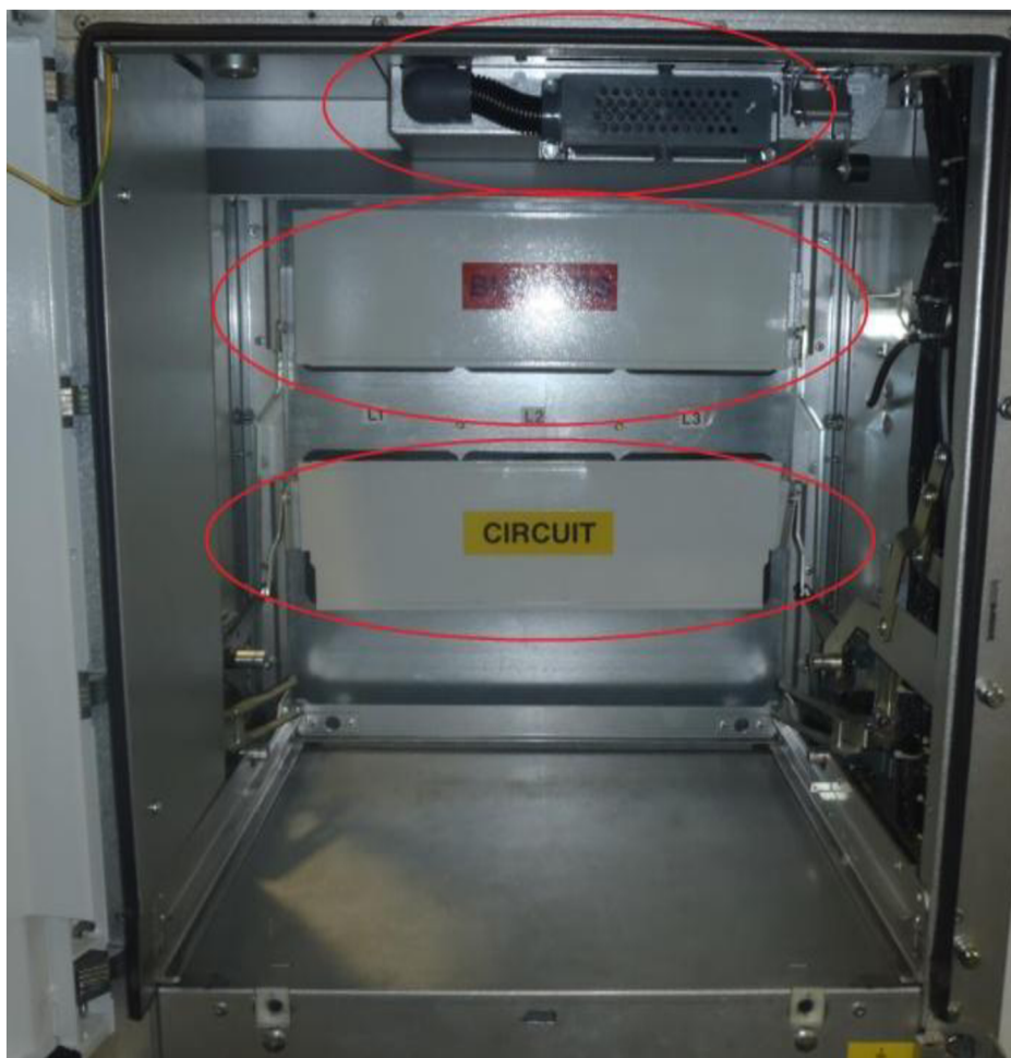
Obr. 18 Oddiel vypínača, s vyznačenými možnými miestami vzniku čiastkových výbojov
