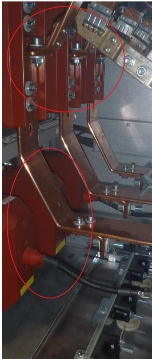
Obr. 24 Oddiel prívodu s vyznačenými možnými miestami vzniku čiastkových výbojov
