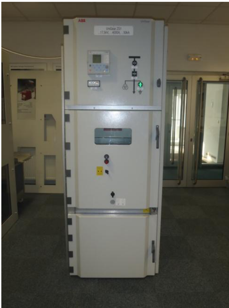
Obr. 16 Rozvádzač ABB UniGear ZS1 s parametrami 12,5 kV, 2500 A, 50 kA/3s
