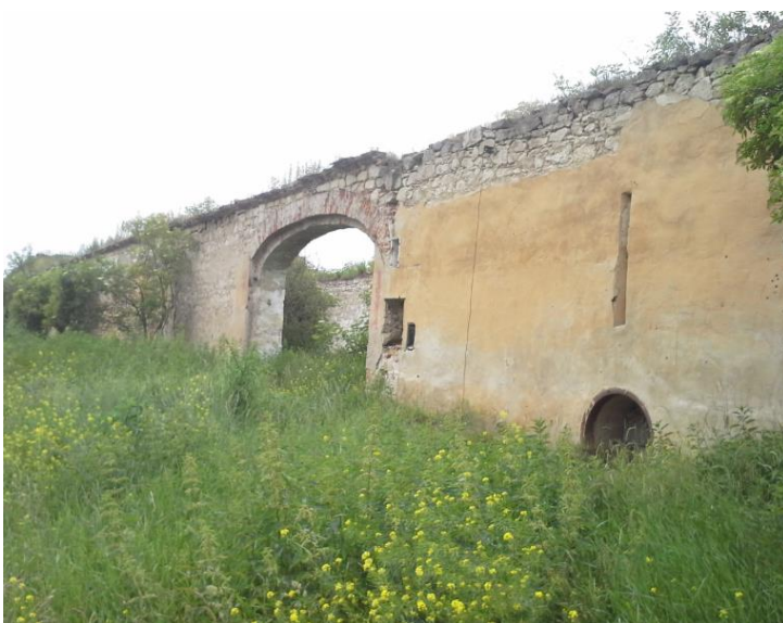
Obr. č. 2 – Zbytky technického zázemí statku
