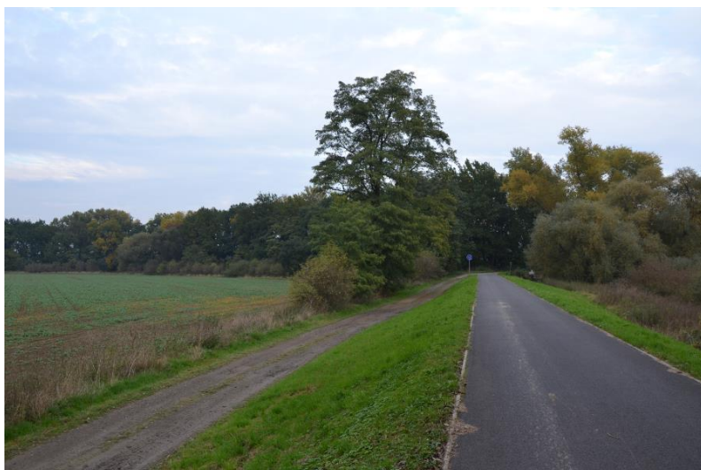
Obr. č. 7 – Pohled na nově vzniklou cyklostezku a původní část lesa
