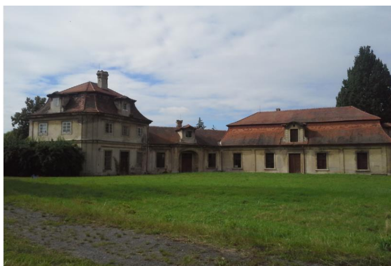
Obr. č. 6 – Přístavba zámku v Hoříně
