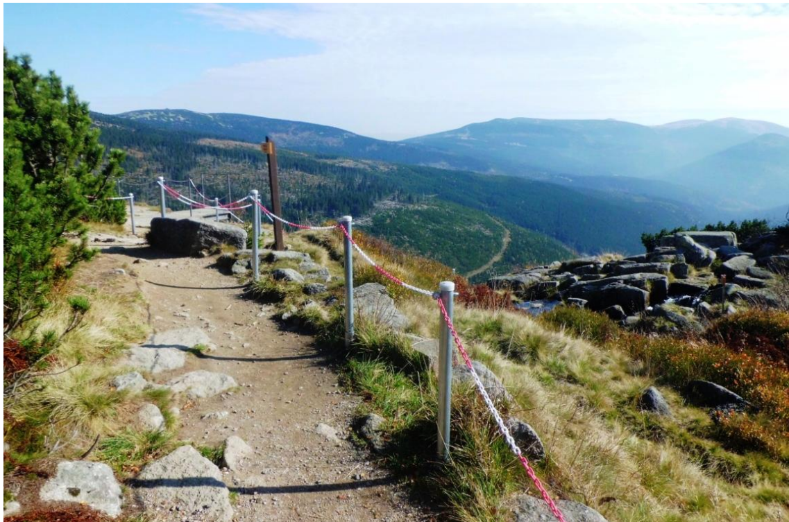
Obrázek 12 Ochranné zábradlí u Pančavského vodopádu. Zdroj: vlastní foto, 10. 10. 2014
