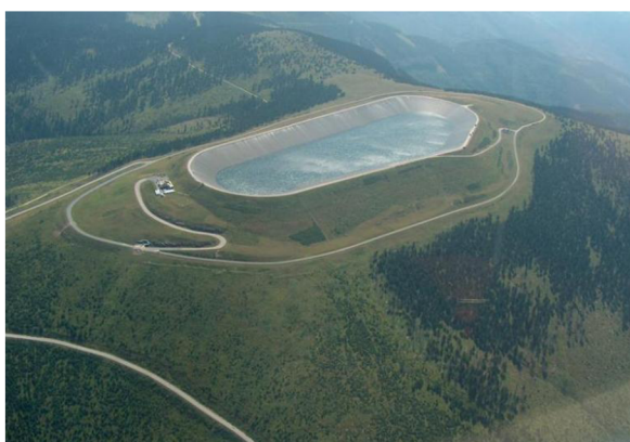
Obr. 1.1 Přečerpávací vodní elektrárna Dlouhé Stráně [1].
