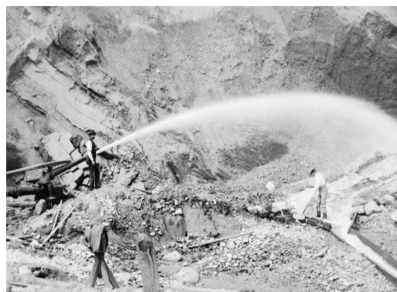
Obr. 1.4 Těžba zlata vodním proudem [4].
